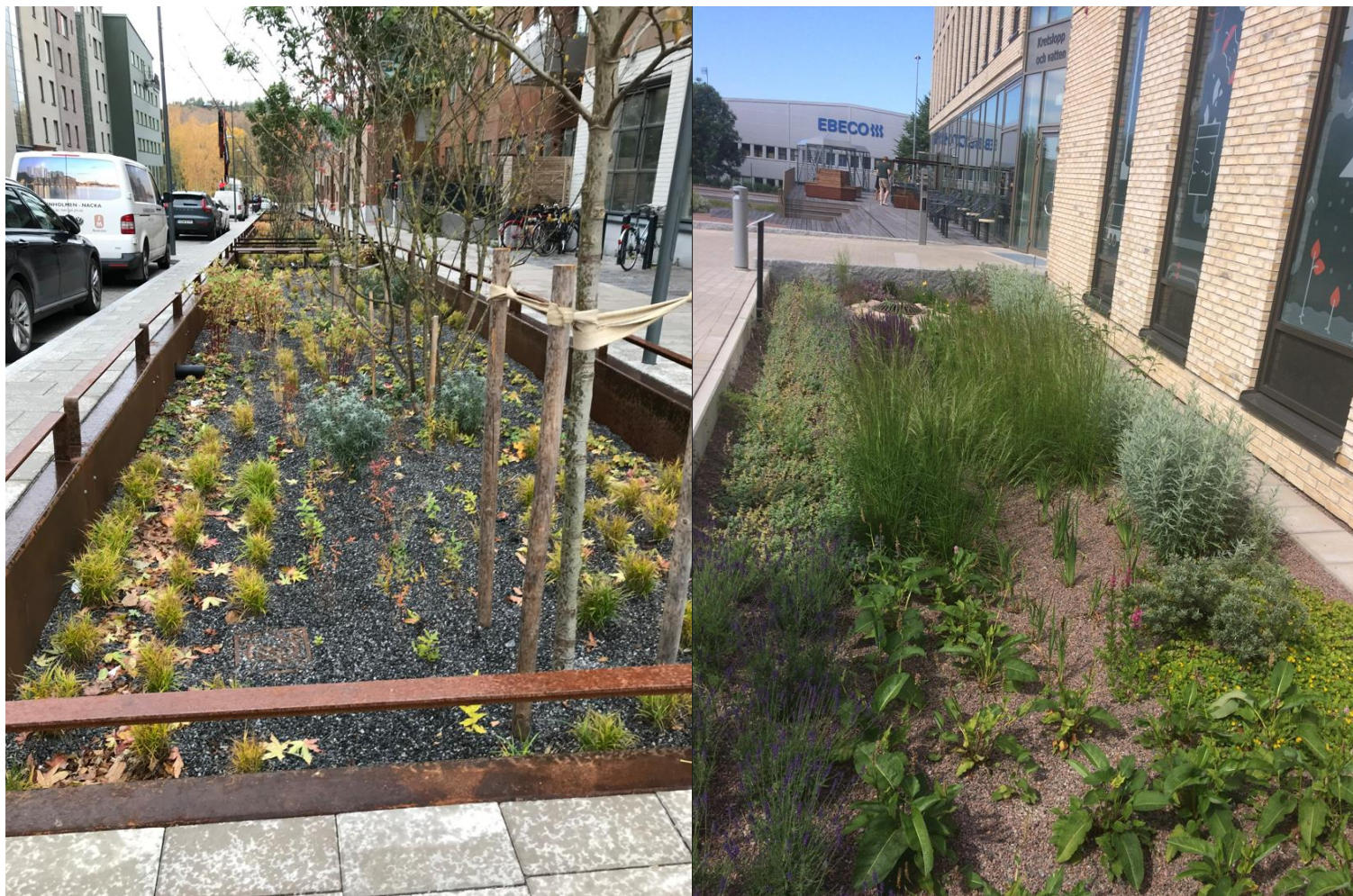
Figur 11: till vänster: Nedsänkta biofilter, Settergatan Stockholm, fotograf: Sofia Augustsson, till höger: Nedsänkta biofilter, Alelyckan GBG, fotograf: Linnéa Lundberg.
